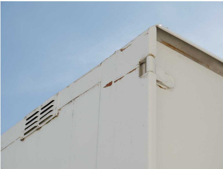
Bild 15 linke Seite Seitenwand links korrodiert
