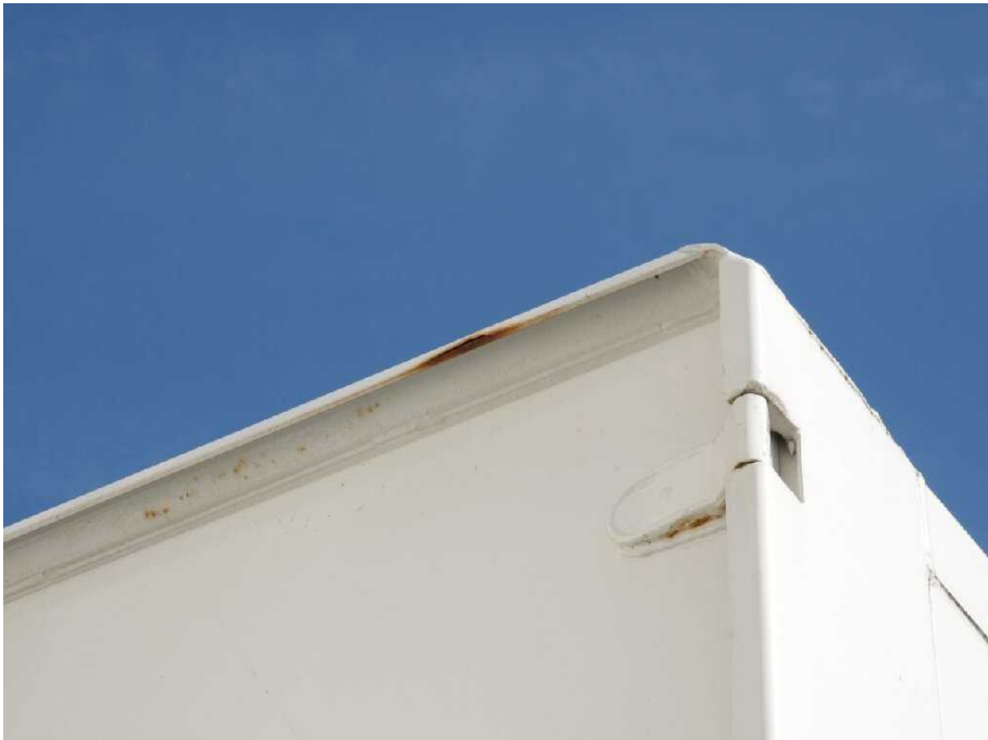
Bild 14 Dach Dachholm rechts korrodiert
